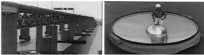
Σχήμα 5.14: Σεισμική μόνωση της γέφυρας Benicia Martinez, California
