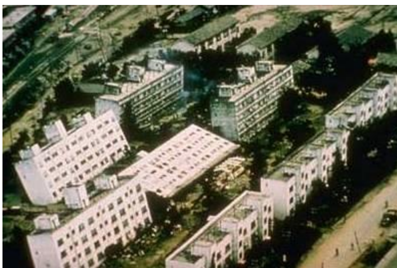
Σχήμα 6.1: Ρευστοποίηση εδάφους (Niigata 1964)
