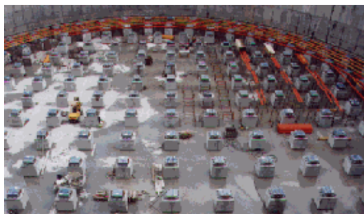
Σχήμα 7.25: Διάταξη εφεδράνων σεισμικής απομόνωσης
