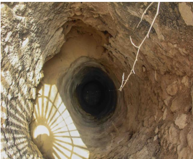
Εικόνα 5: Αγωγοί μεταφοράς ομβρίων από το οροπέδιο του Σεραπείου στην δεξαμενή του Νειλόμετρου (Σπανούδη,2020)
