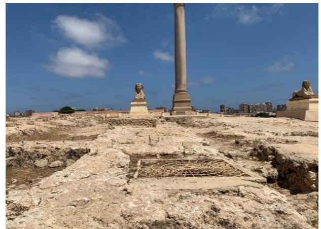
Εικόνα 3: Ανοίγματα συλλογής ομβρίων από το οροπέδιο του Σερατείου (Σπανούδη, 2020)
