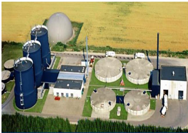
Εικόνα 1: Πανοραμική άποψη μονάδας αναερόβιας χώνευσης αποβλήτων
