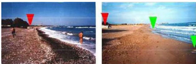
Εικόνες 3 & 4: Η ανάπλαση της ακτής Θεολόγου, του Δήμου Πεταλούδων Ρόδου, με κατασκευή διάταξης ΣΠΑΑ 27 προβόλων, χωρίς τεχνητή αναπλήρωση
