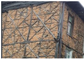
Σχήμα 4. Τοίχοι με ξυλοδεσιές (τσατμάς και μπαγδαντί).
