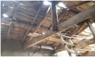
Σχήμα 5. Αυτοφερόμενη και εδραζόμενη στέγη αντίστοιχα
