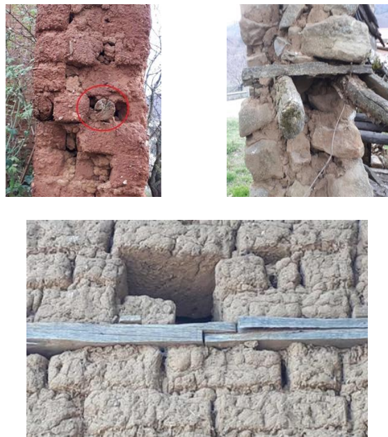
Σχήμα 3. Διαζώματα στις τοιχοδομές.
