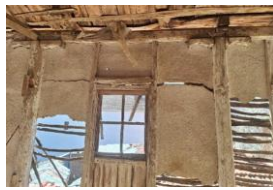
Σχήμα 4. Τοίχοι με ξυλοδεσιές (τσατμάς και μπαγδαντί).
