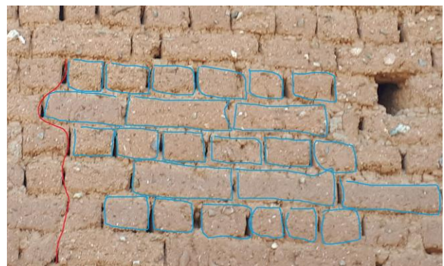
Σχήμα 8. Όψη υπερμπατικής τοιχοποιίας.
