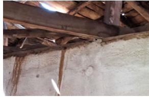
Σχήμα 5. Αυτοφερόμενη και εδραζόμενη στέγη αντίστοιχα
