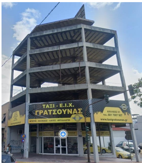
Σχήμα 1. Υφιστάμενη κατάσταση του υπό μελέτη κτιρίου.
