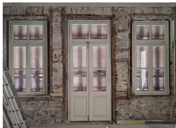
Σχήμα 2. Εσωτερική όψη τοιχοποιίας με φριγγιά (Αρχείο ΕΦΑΛΕΣ, Αρ. Πρ. 472558/15-11-2024).
